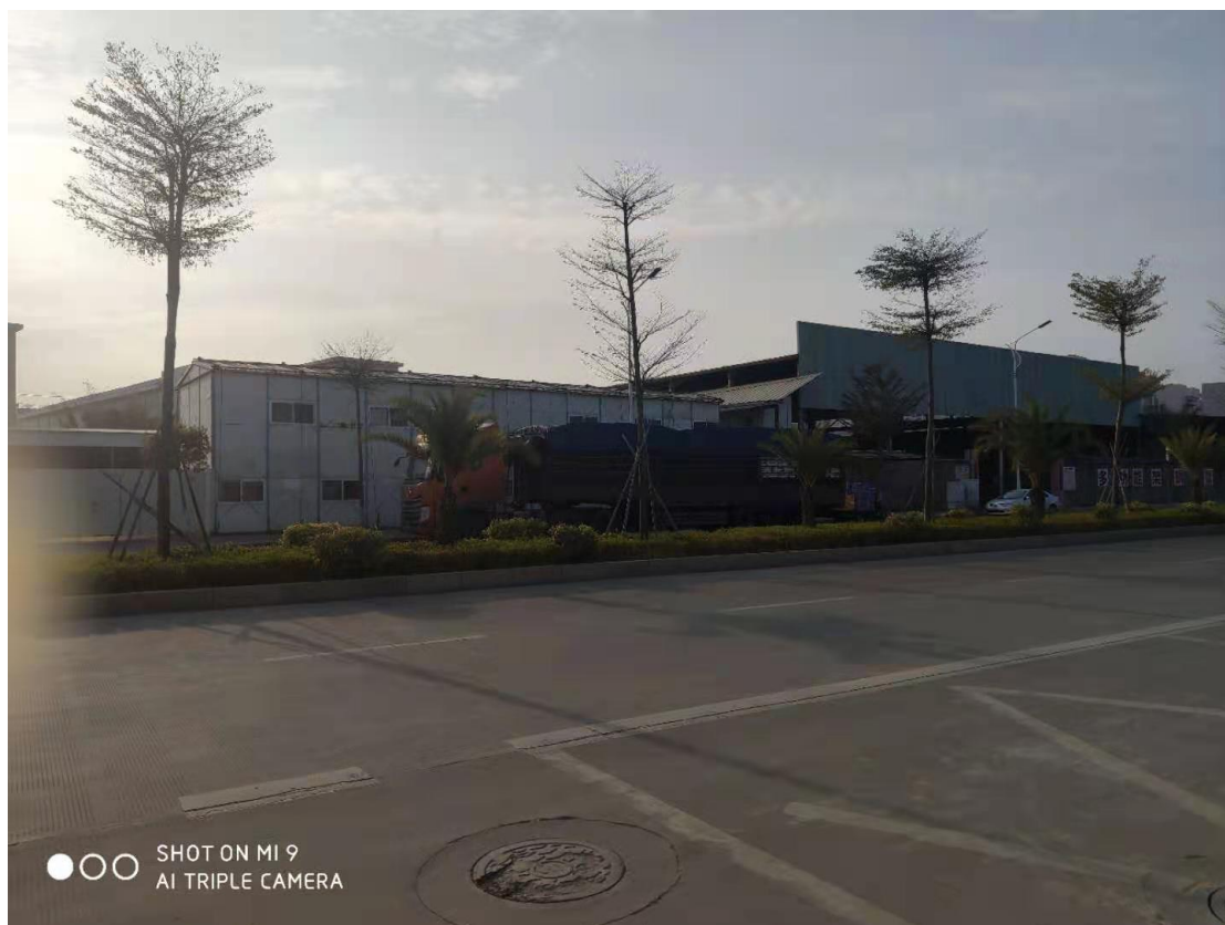
场地现搭建有临时板房及器械堆场，环境满足施工要求
